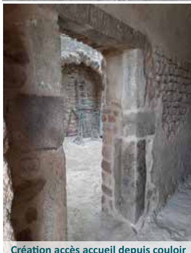
Ouverture accès sanitaire : transformation d'une fenêtre en porte
