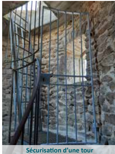
Remplacement plancher terrasse et gardes corps
