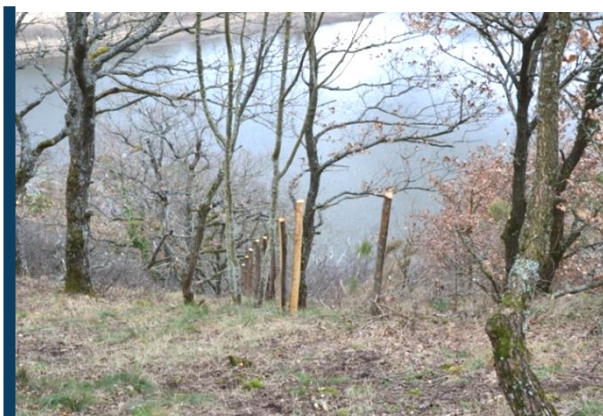
Photo 8 : pose de piquets dans les pentes de la pointe de Chamousset
