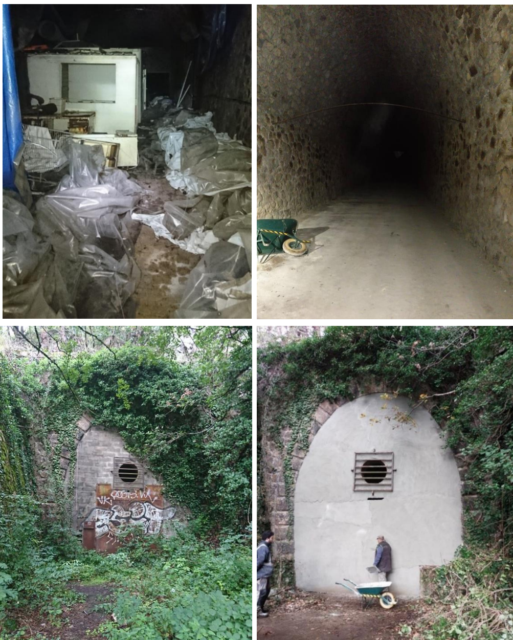
Photo 18 : Travaux ancienne champignonnière
