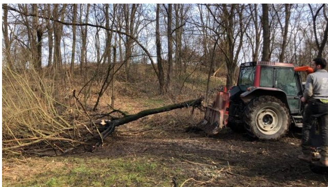
Photo 30 : Arrachage des saules au treuil
