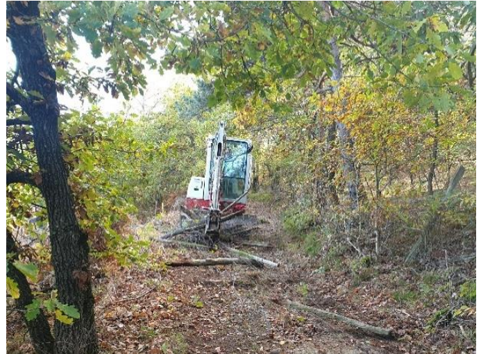
Photo 13 : suppression de clôtures
