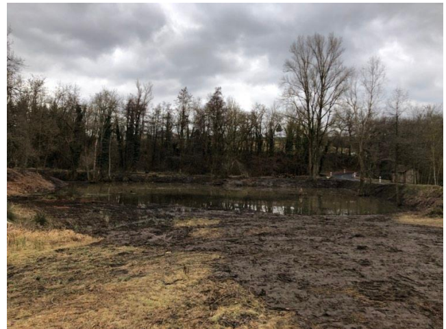
Photo 34 : Zone humide de Bécizieux après travaux
